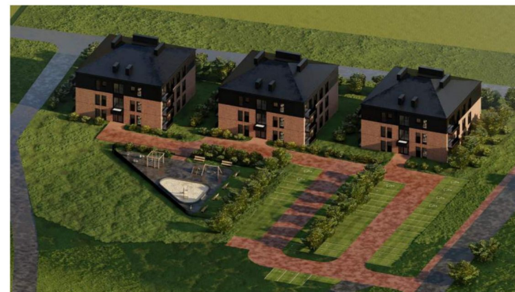
WIDOK OD STRONY PÓŁNOCNO WSCHODNIEJ
