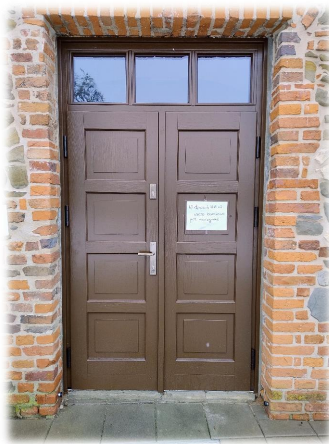
Wymienione drzwi wejściowych – wieża zamkowa
